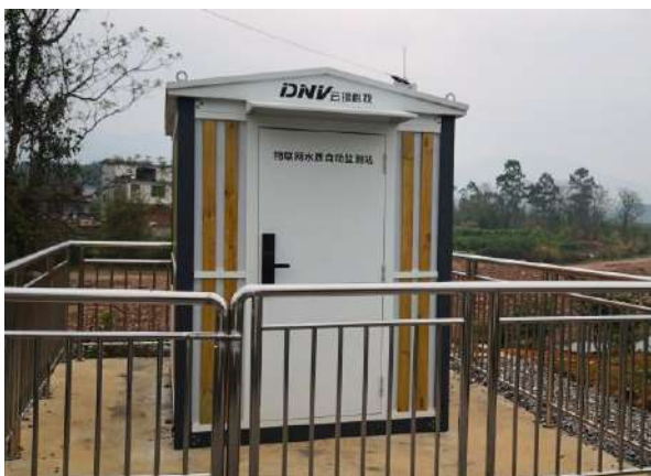
光大水务南宁黑臭水体治理监测站
